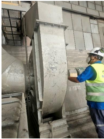
รูปที่ 10 การตรวจสอบพัดลมดูดอากาศของถุงกรอง
