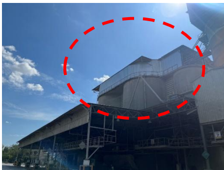
รูปที่ 58 ติดตั้งแผ่นเมทัลชีทบนไซโลปูนผง
