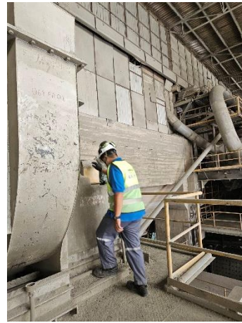
รูปที่ 10 การตรวจสอบพัดลมดูดอากาศของถุงกรอง
